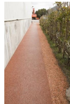
▲ 施工された K-グラウンド
