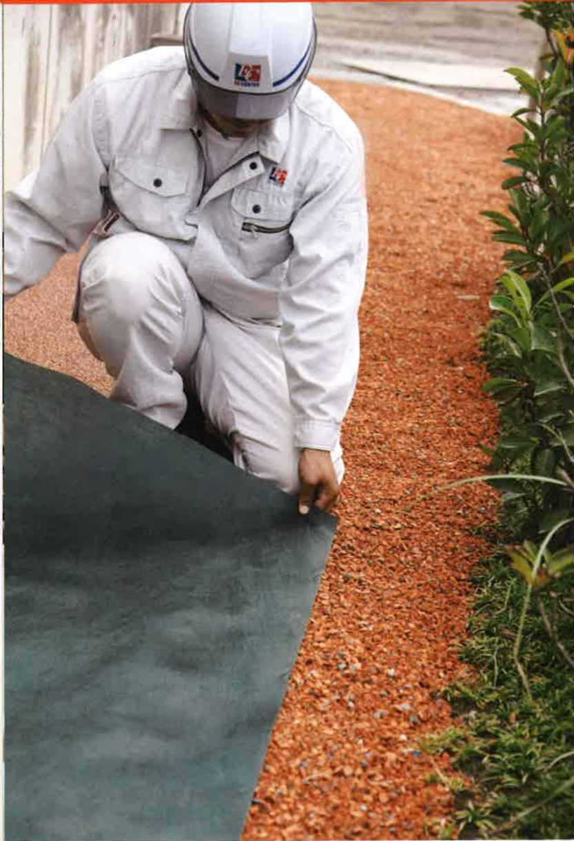
住まいのアプローチに瓦チップを敷設。防草シートと合わせれば、除草効果は抜群
