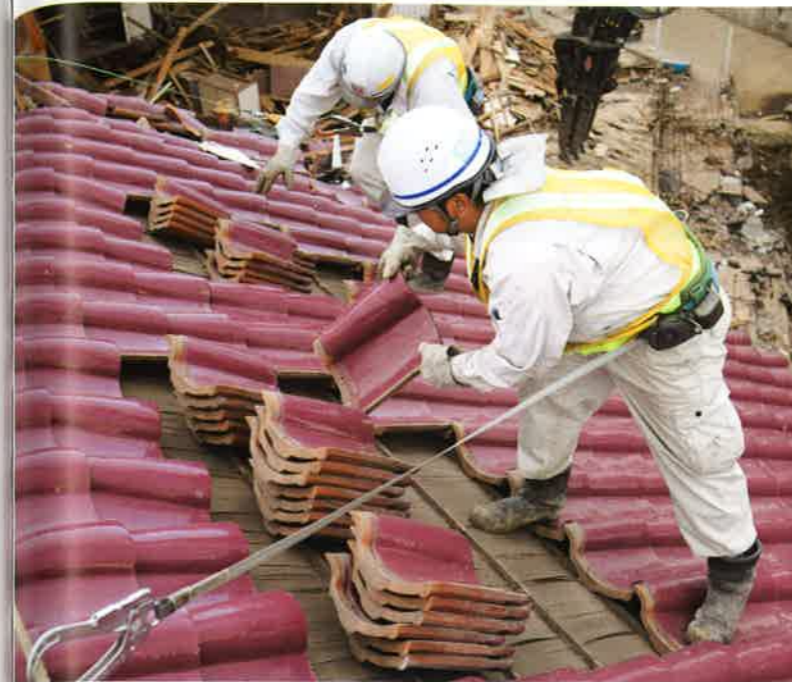
解体工事は人と機械の共同作業。瓦は資源として再利用するので扱いは丁寧に
