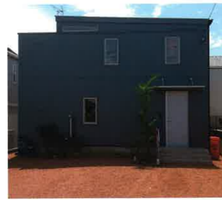
瓦チップを外構に敷き詰められた例。柔らかなオレンジ色は目にも優しい
