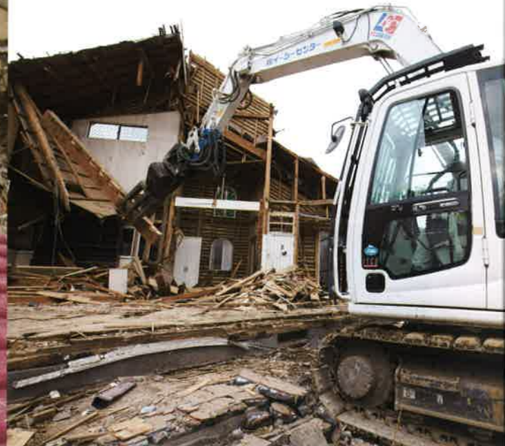
木造住宅の解体工事現場。障害物の感知システムを搭載した特殊な重機で慎重に作業が進められる
