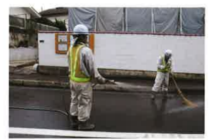
解体工事中の清掃作業。近隣への気配りが徹底しているので安心して
